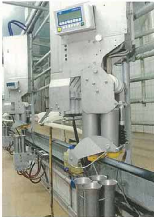
Die Technik an den Melkplätzen ist recht aufwändig und nimmt viel Platz ein.
